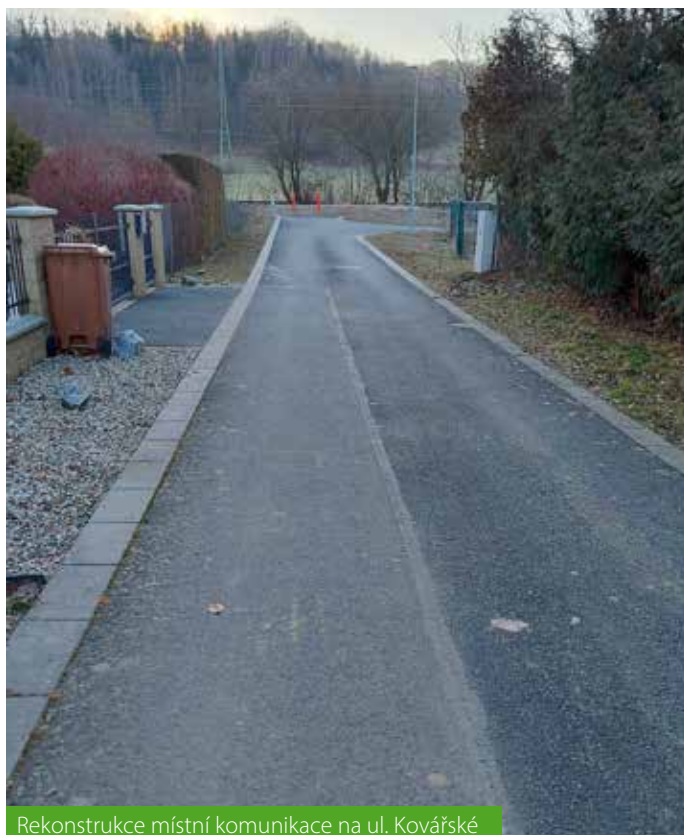
Rekonstrukce místní komunikace na ul. Kovářské
