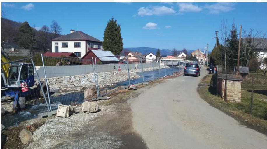
Přípravné práce na budování protipovodňové zdi na ul. Rybářská
