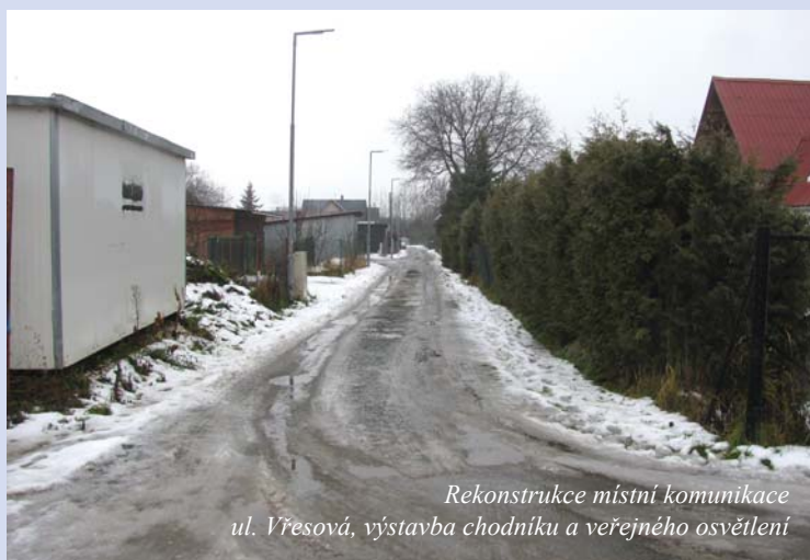
Rekonstrukce místní komunikace ul. Ve Dvoře
