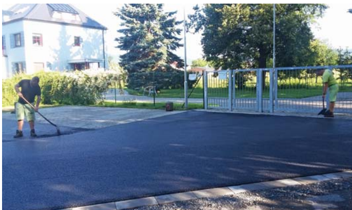
Pokládání vrchní vrstvy asfaltbetonu u brány Mateřské školy
