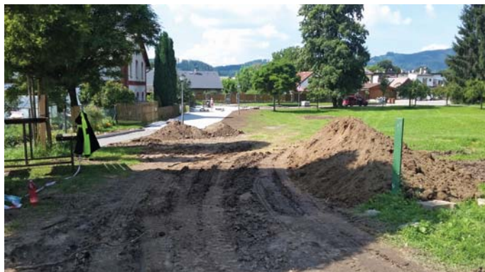
Prodloužení ul. Zámecká před dokončením
